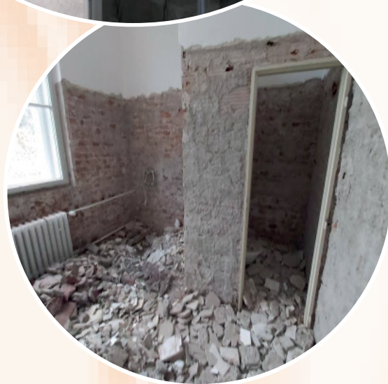
stavební práce při rekonstrukci koupelny
