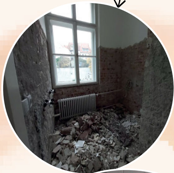
stavební práce při rekonstrukci koupelny
