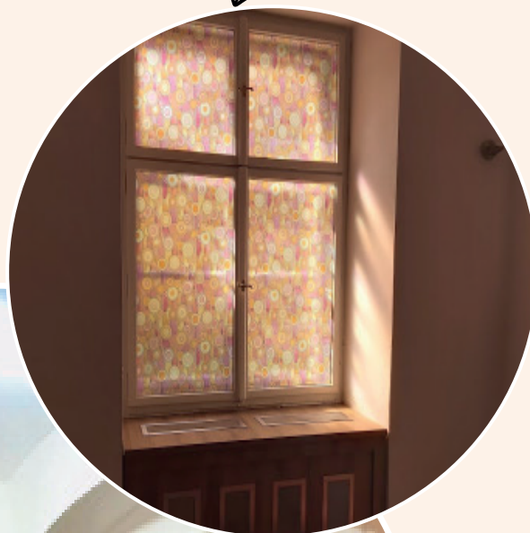
okno ve vinárně s fólií imitující vitráž
