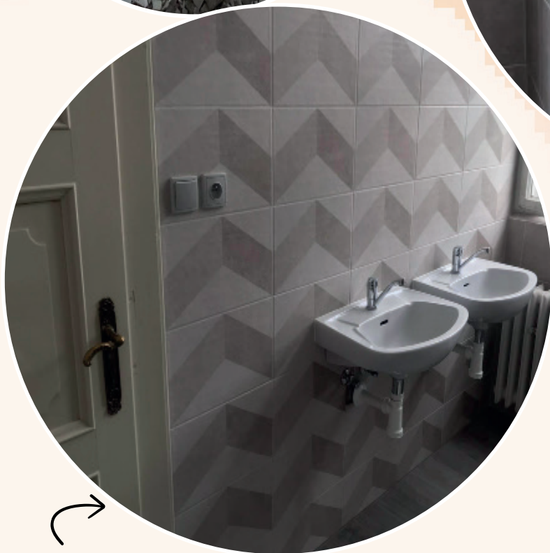
koupelna v šatně po rekostrukci
