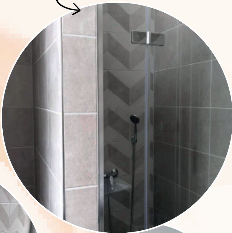
koupelna v šatně po rekostrukci
